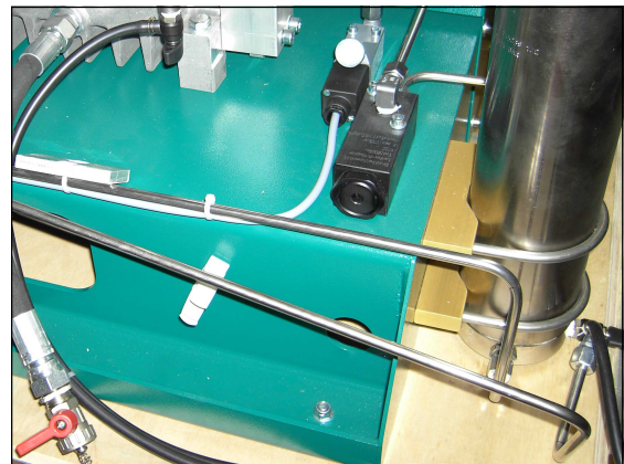
Zu entfernende Rohrleitung
