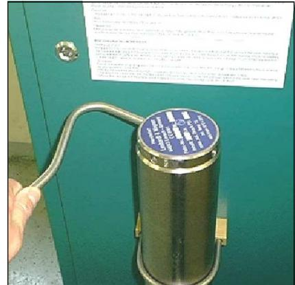
Abb. 1 - Abschrauben des Filtergehäuse-Deckels
