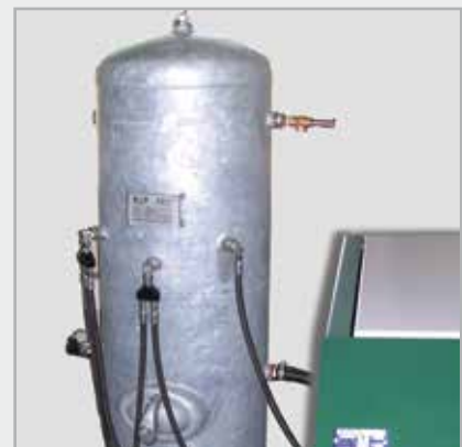
150 I Vordruckbehälter für die Kondensatrückführung
